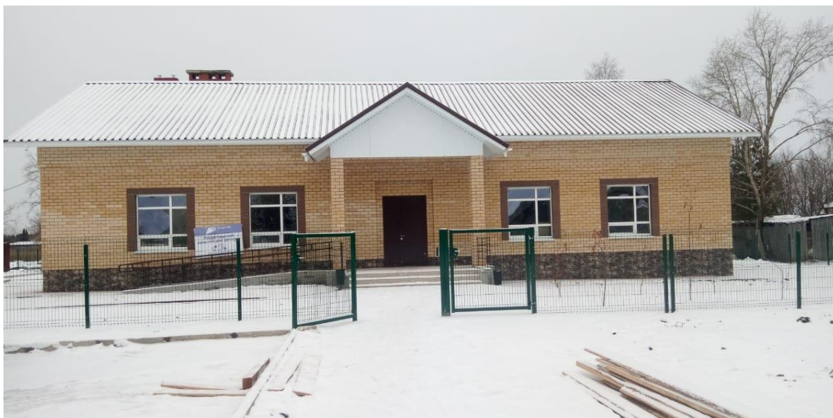
ЗАО "Мамадышстрой" г. Мамадыш (Директор Гараев Зуфар Маликович) осуществляло функции подрядчика на объекте «Строительство сельского дома культуры в Уржумском районе Кировской области, село Рождественское, ул.Первомайская д.33».
